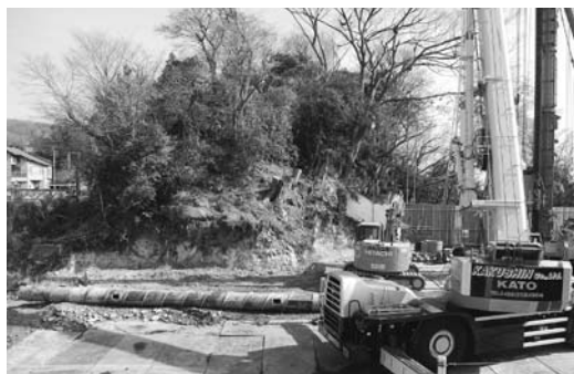
築山壊しが進む駐輪場建設
