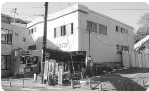
解体前の駅前自転車駐車場
